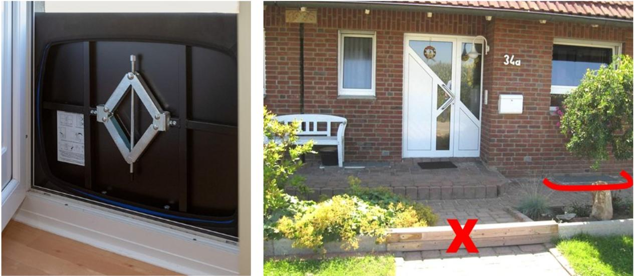
Abb. 4-3: Objektschutzbeispiele: Mobile Türdichtung (links); Aufmauerung eines Lichtschachts (rechts)
