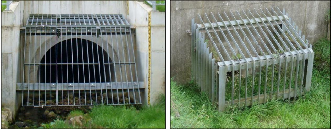
Abb. 4-10: Raumrechen am Einlauf einer Verrohrung (links: FISCHER TEAMPLAN; rechts: DWA-M 522:2015)
