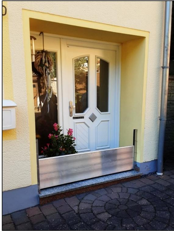
Abb. 7-3: Mobiler Hochwasserschutz in Form eines Dammbalkensystems in Ariendorf zum Schutz des Hauseingangs
