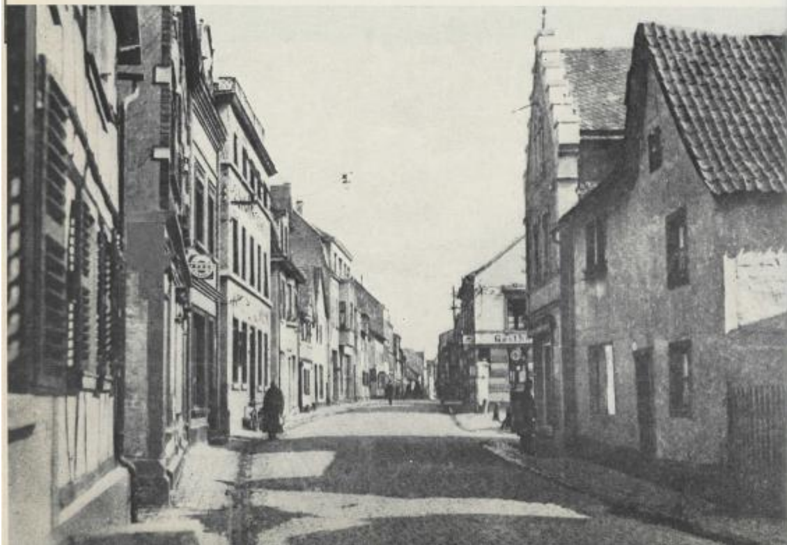
Abbildung 21: Historische Aufnahmen der Innenstadt (Quelle: Stadt Bad Hönningen)
