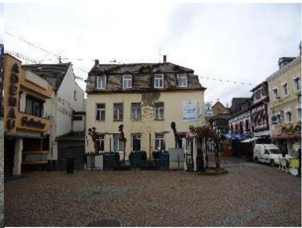
Abbildung 95: Rüssel Gebäude, nördlich Platzseite
