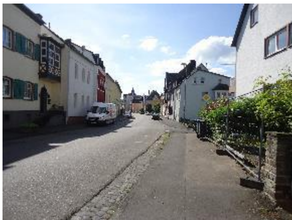
Abbildung 82: Einmündung „Schwarzer Weg“ (rechts) auf „Hauptstraße“
