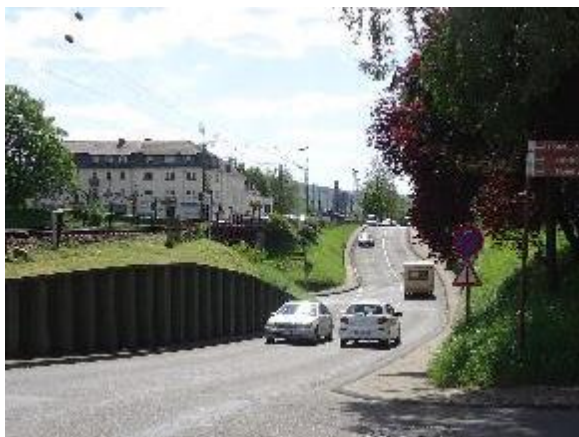
Abbildung 84: Pkw Unterführung „Walther-Feld-Str.“/Hohe Hausstr. (links)
